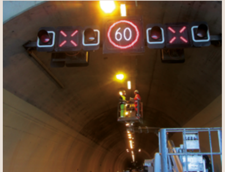
Inspektion der Signalisation im Tunnelportal Autobahn A16, Delémont
